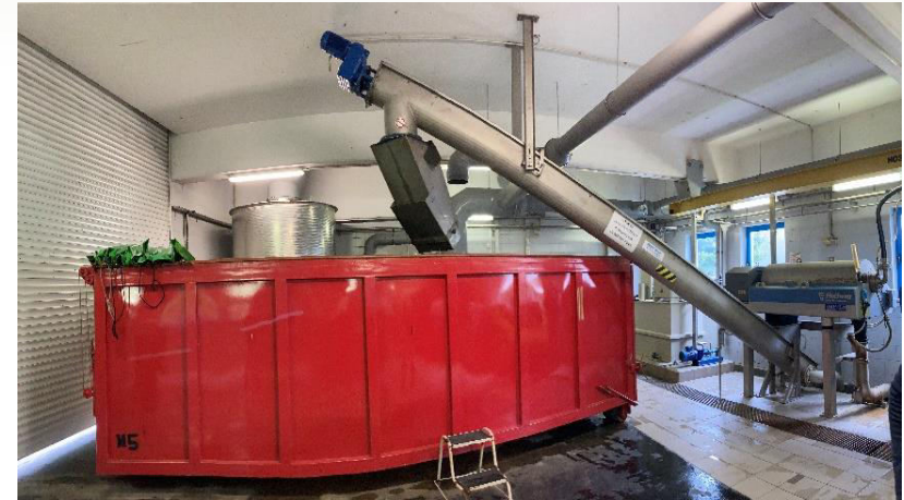
Zgoščevanje blata s centrifugo na ČN Črnuče
