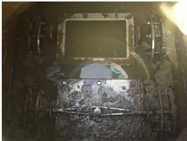
Primera nepravilne izvedbe čistilnega kosa.
