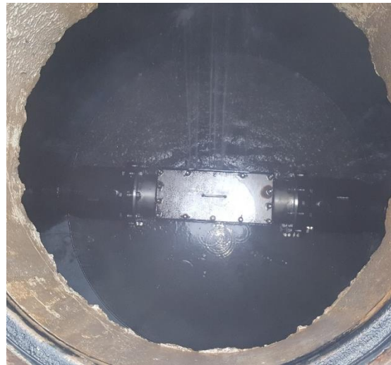
Primera nepravilne izvedbe čistilnega kosa.
