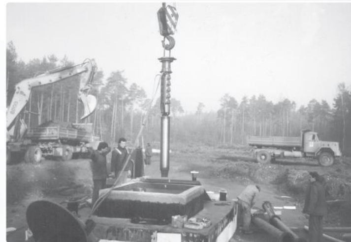
VODNJAK DOBROVCI 1989: SPUŠČANJE ČRPALKE
