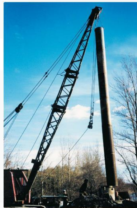
1999: SPUŠČANJE VODNAŠKE KONSTRUKCIJE V VRTINO PRI MARIBORSKEM OTOKU
