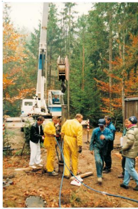
1999: SPUŠČANJE ČRPALKE V VODNJAK NA SELNIŠKI DOBRAVI
